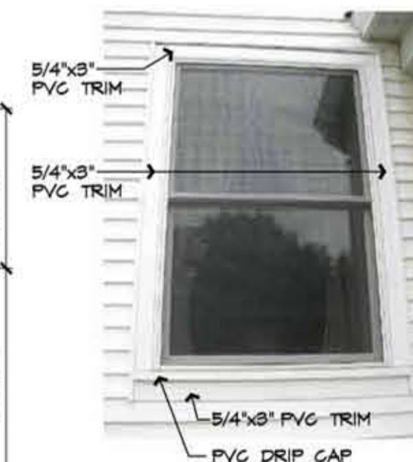
EXISTING WINDOW TRIM ELEVATION SCALE: N.T.S.
